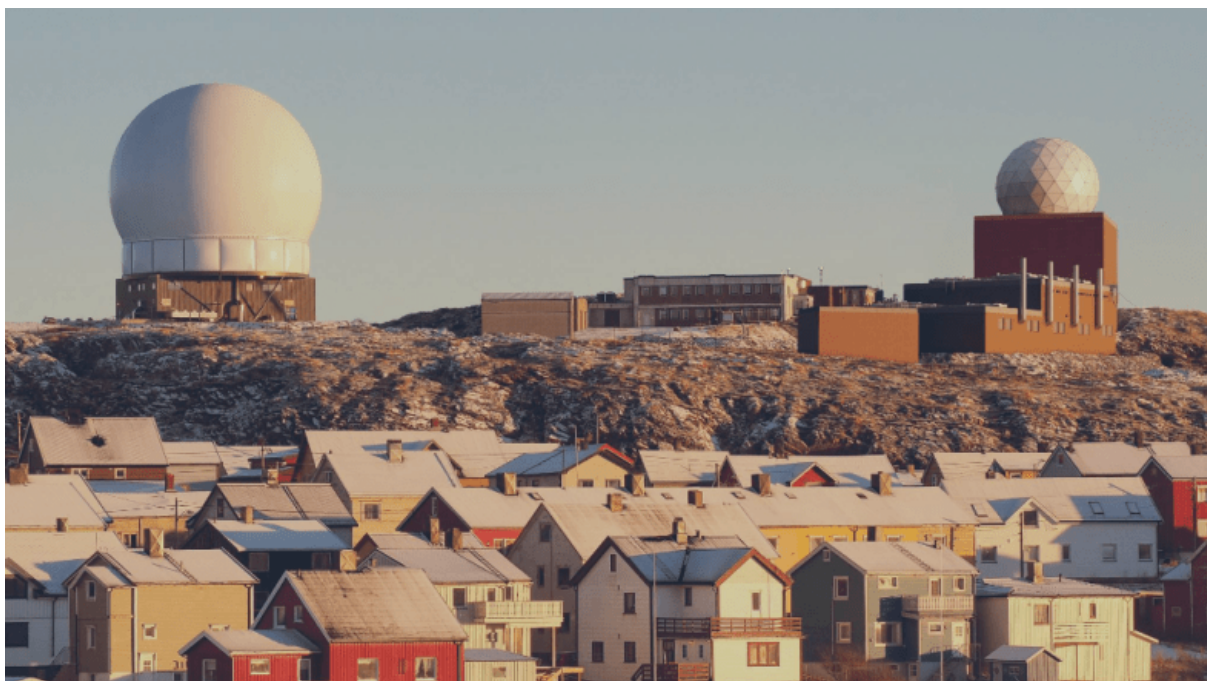
GLOBUS-radaranlegget Vardø (foto: Forsvarets etterretningstjeneste)
